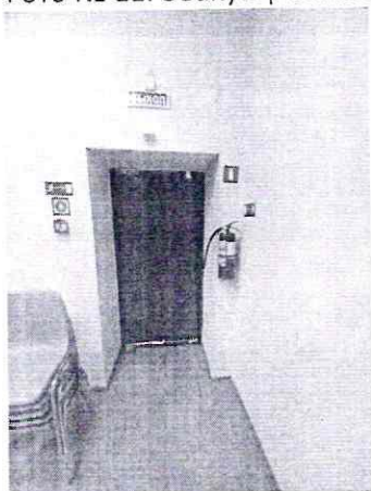
Фото № 11. Эвакуационные пути
