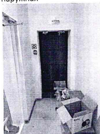
Фото № 12. Эвакуационные пути/лестница наружная
