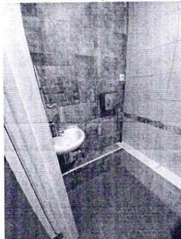
Фото № 16. Санузел для МГН
